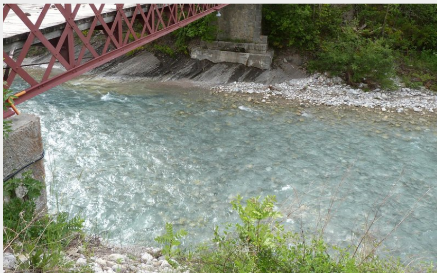
Traversée du Petit Buëch à Veynes (CDRP05)
