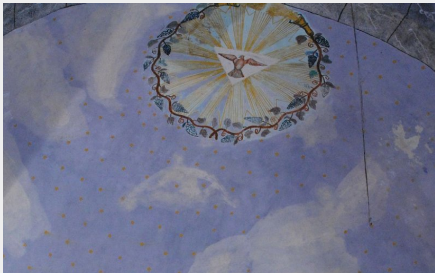
Chapelle Saint Guillaume (OT Guillestrois-Queyras)
