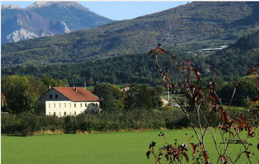
Crédit photo : Vue (Le moulin de Montrond)
