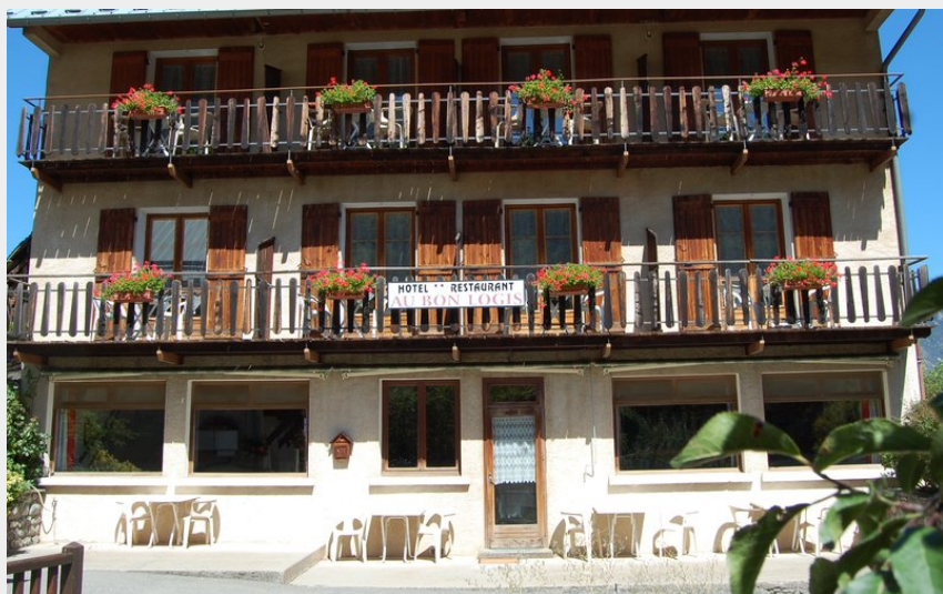
Crédit photo : vue extérieure (hôtel Au Bon Logis)
